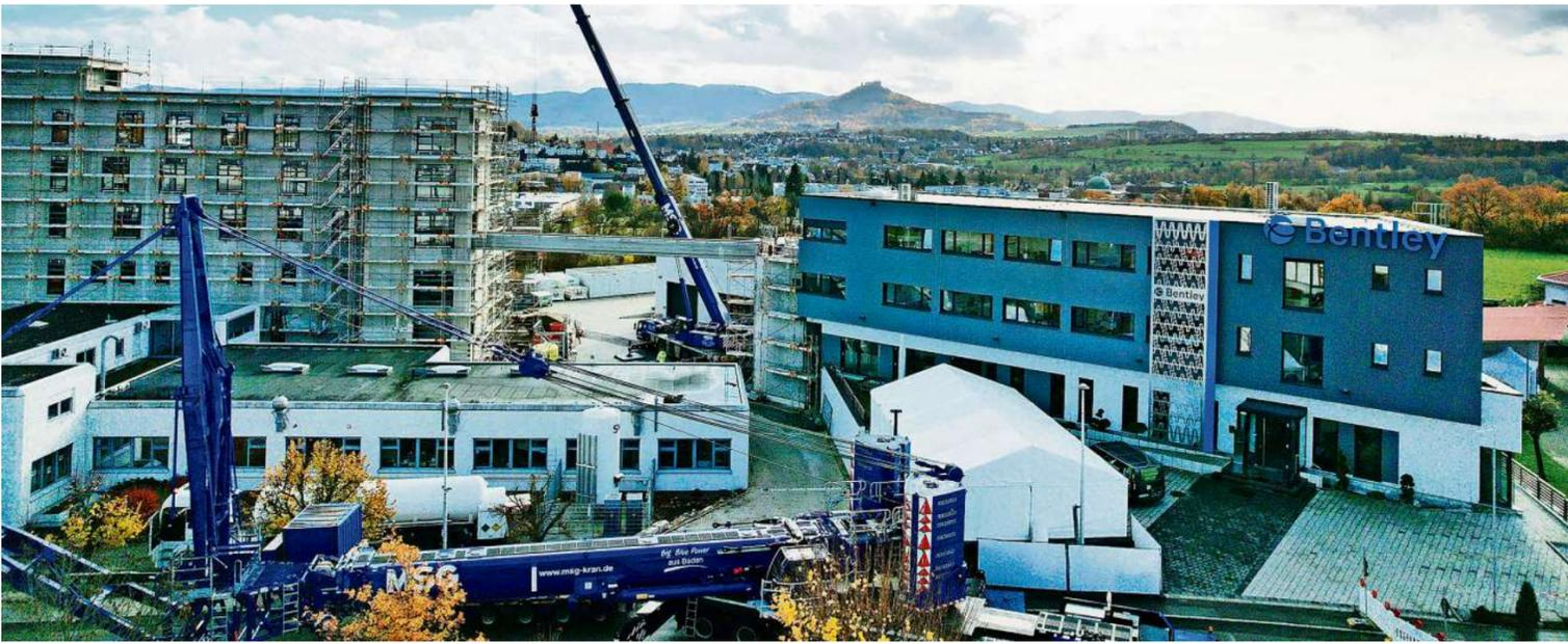
Drohnenaufnahme vom Einsetzen der knapp 24 Meter langen und 54 Tonnen schweren Brücke zwischen den Bentley-Gebäude Admin I und Admin II, die Aufnahme entstand im November 2022
