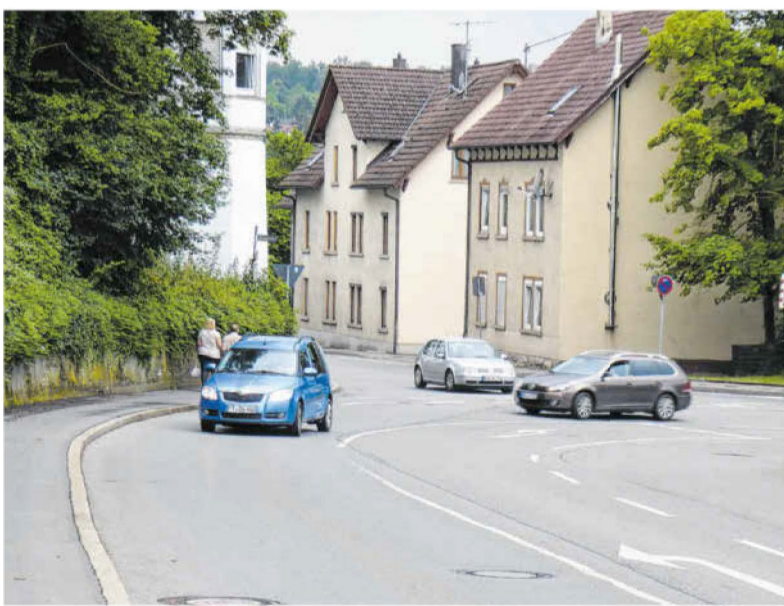
Wenn auch im oberen Teil der Neustraße ein Radfahrstreifen angebracht wird, bedeutet dies, dass die alten Fahrbahnmarkierungen abgefräst werden müssten.
