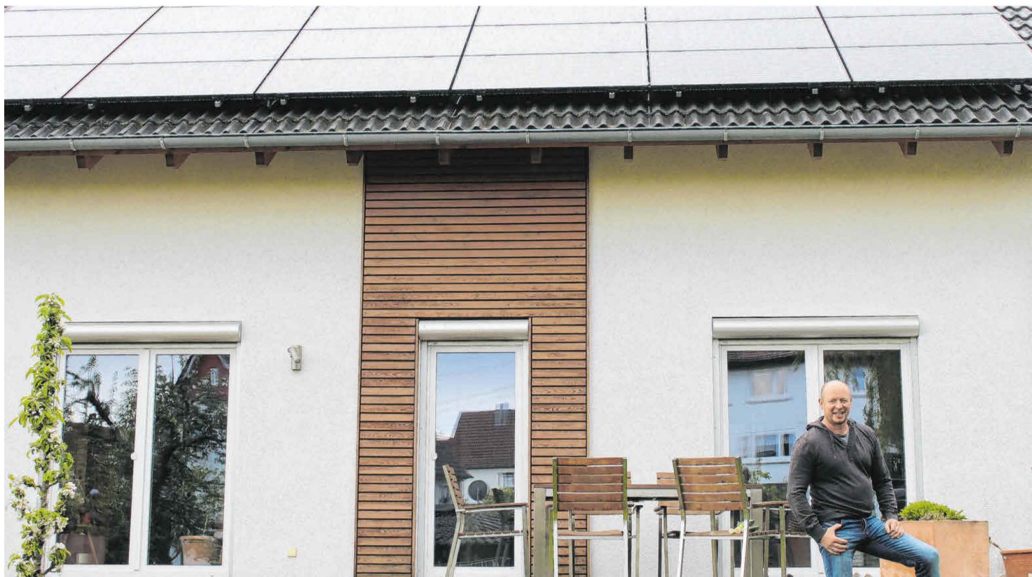
Bei Jürgen Baumer wird der Klimaschutz auch im privaten Bereich groß geschrieben. Sein Eigenheim in Sickingen ist ein Energiehaus in Holzständerbauweise und „ummantelt“ in Holz-Dämmzellulose! Ausgestattet mit Photovoltaik, Solarthermie und Wärmepumpe mit Fußbodenheizung. Fotos: Sabine Hegele
