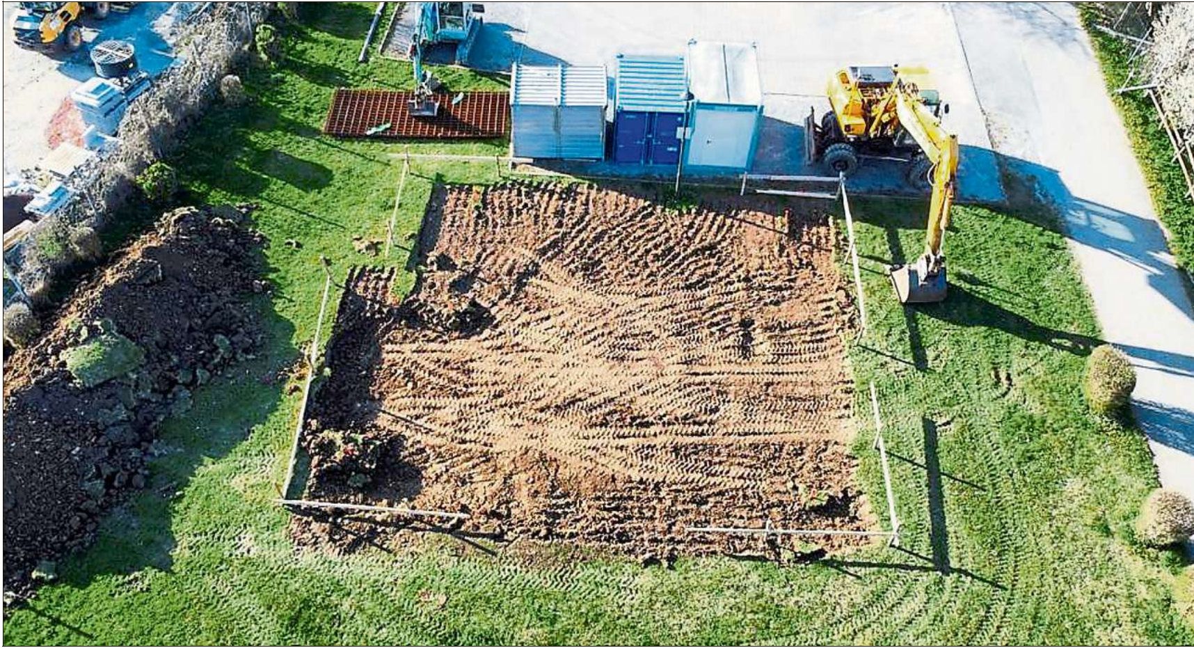
Ein Blick von oben auf die Baustelle hinter der Aucherthalle: Hier haben die Arbeiten zur Errichtung des neuen Jugendraums begonnen.
